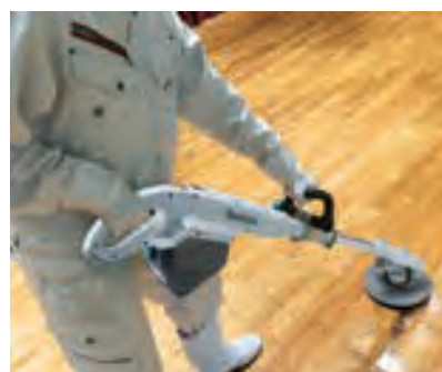
Limpieza y eliminación con cera de resina
