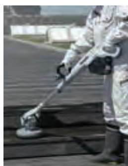
Limpieza de suelos exteriores
